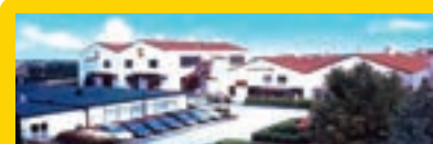
① 栃木工場 (栃木県塩谷郡) 製造品目: 家電用ホース・産業用ホース・樹脂成形品
