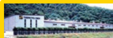
③ 岡山工場 (岡山県備前市) 製造品目: ゴムシート・ゴムマット
