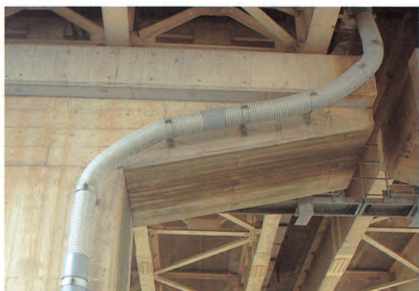
TNTフレキ管 施工例
