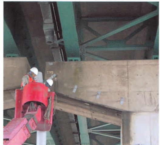
2.塩ビ管撤去・固定金具取り付け
