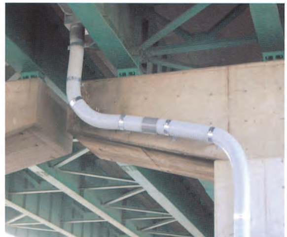
4.TNTフレキ管取り付け(2)
