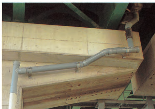
塩ビ管 施工例
