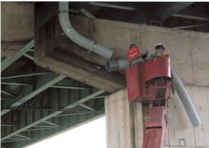
3.TNTフレキ管取り付け(1)
