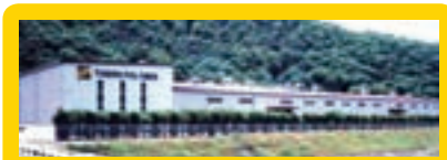
③ 岡山工場 (岡山県備前市) 製造品目：ゴムシート・ゴムマット
