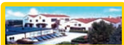
① 栃木工場 (栃木県塩谷郡) 製造品目：家電用ホース・産業用ホース・樹脂成形品
