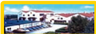
① 栃木工場 (栃木県塩谷郡) 製造品目：家電用ホース・産業用ホース・樹脂成形品
