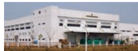
広州泰賀塑料有限公司 工場増設部分
