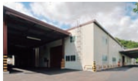
倉庫棟東側全景
